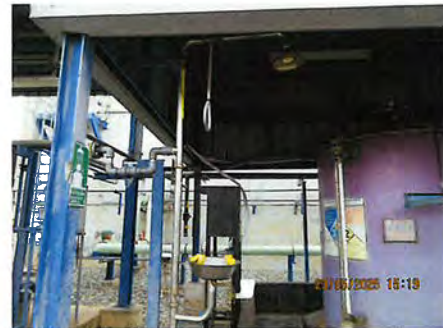
ภาพที่ 2-56 ฝักบัวชำระล้างร่างกายและที่ล้างตา (Safety Shower&Eye Washer)
