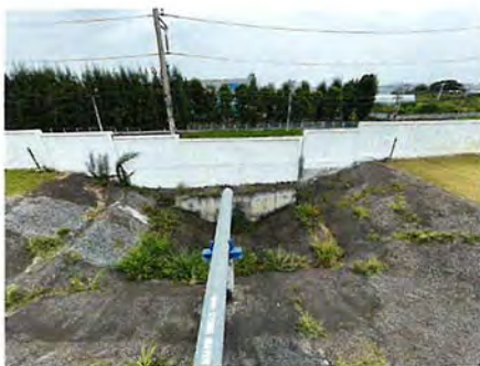
ภาพที่ 2-27 จุดระบายน้ำฝนที่เชื่อมต่อกับ ระบบระบายน้ำฝนของนิคมฯ
