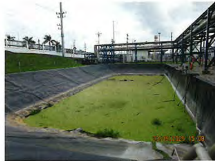
ภาพที่ 2-16 บ่อกักน้ำหล่อเย็น
