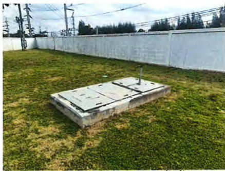
ภาพที่ 2-11 จุดระบายน้ำทิ้งจากบ่อกักน้ำทิ้งรวมไปยังระบบ บำบัดน้ำเสียส่วนกลางของนิคมฯ
