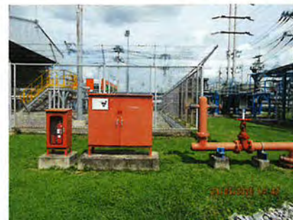
ภาพที่ 2-40 ระบบป้องกันเพลิงไหม้และระบบดับเพลิงของโครงการ
