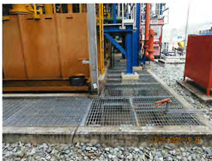
ภาพที่ 2-27 จุดระบายน้ำฝนที่เชื่อมต่อกับ ระบบระบายน้ำฝนของนิคมฯ
